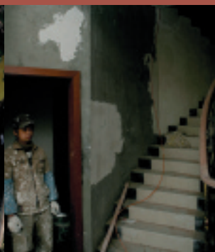
工事中の建物
