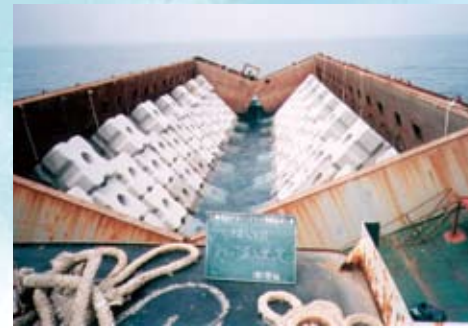
長崎県生月沖5キロの海域でのブロックの沈設作業の様。ハザマは水深80メートルの海底に正確に設計どおりの海底山脈を構築するシステムを開発。流れを考慮して短時間に作業を完了させる技術を確立した。
